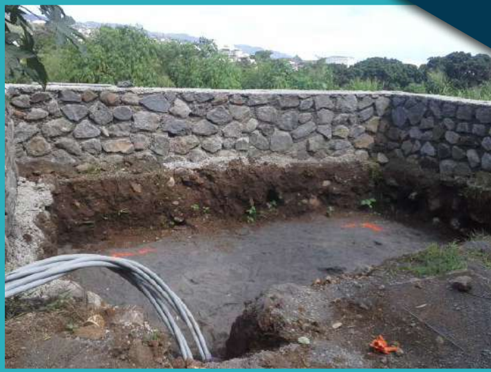
Travaux de renforcement HTA Saint-Joseph
