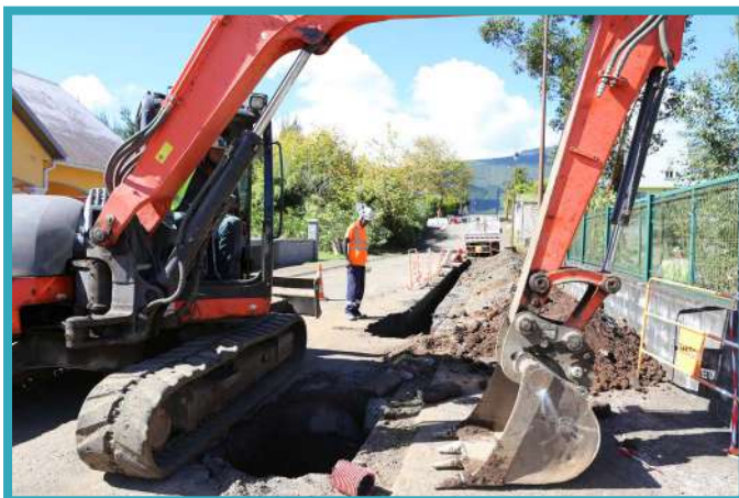
Travaux d'extension HTA 15kva pour alimentation d'un transformateur Plaine des Palmistes
