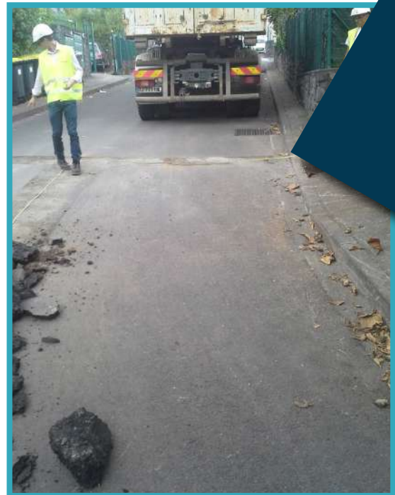
Travaux de renforcement du réseau HTA Saint-Joseph
