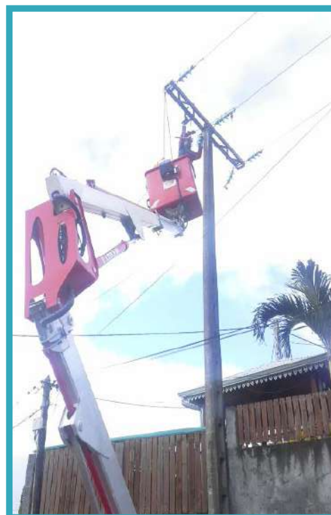
Repose de la ligne aérienne HTA Saint-Denis
