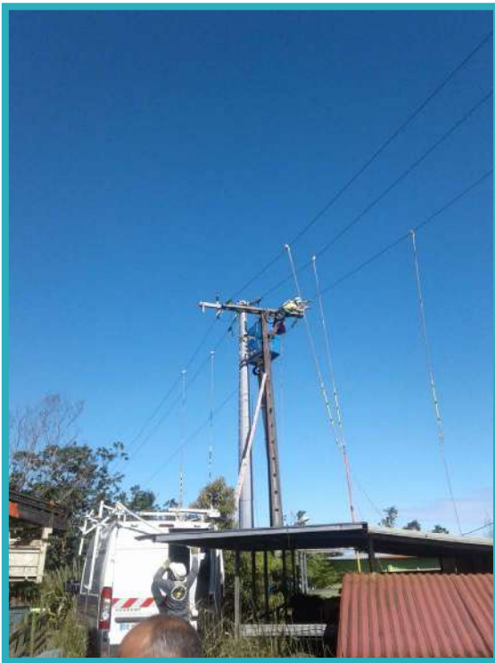
Travaux de renforcement HTA Saint-Joseph
