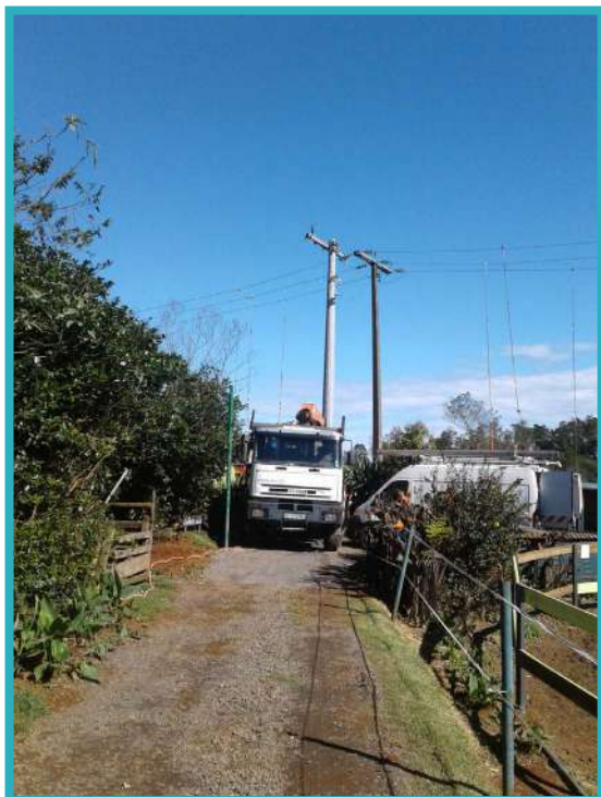
Travaux de renforcement HTA Déroulé du raccordement Saint Joseph
